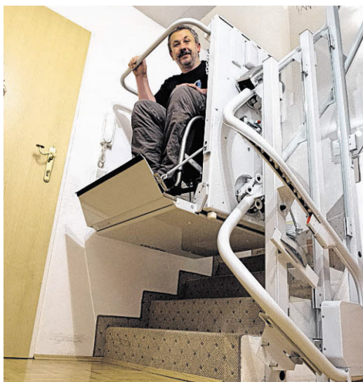
Manfred Fischer verfügt über einen Treppenlift. Dieser kann auch bei engen Stiegen eingebaut werden.
