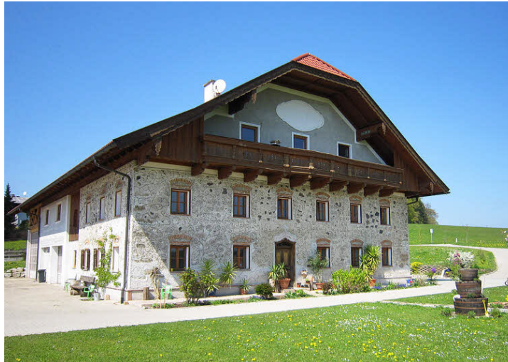
Eine Besonderheit im Flachgau sind die Schlackenputz-Gebäudefassaden. Diese wurden im 19. Jahrhundert von italienischen Wanderarbeitern verbreitet. Die Fassade des 1892 errichteten Obergirlingerhofes wurde 2002 aufwändig saniert.
