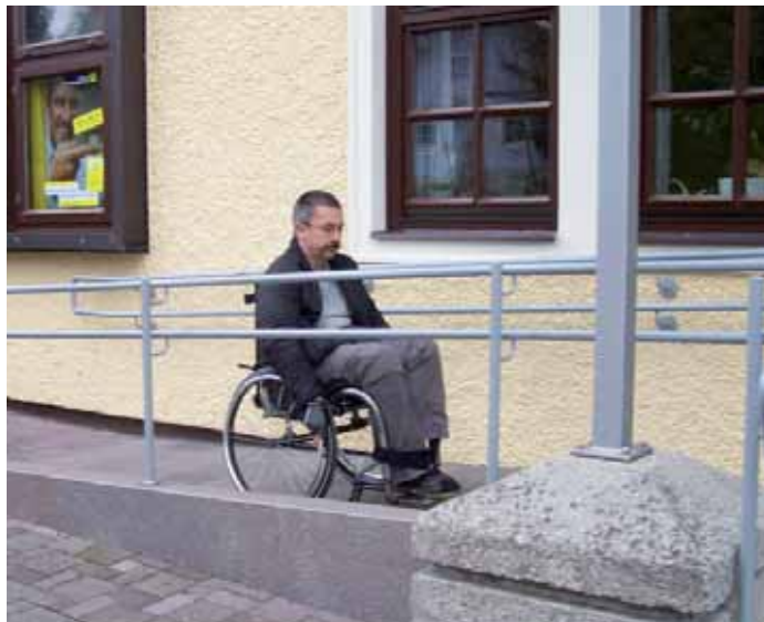
Die neue Rampe zur Raiffeisenbank weist eine geringe Steigung auf und kann mit dem Rollstuhl leicht benützt werden.
