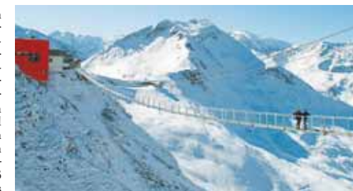
Die 140 Meter lange Hängebrücke am Stubnerkogel ist eine atemberaubende Attraktion in Gastein. Bild: GASTEINER BERGBAHNEN
