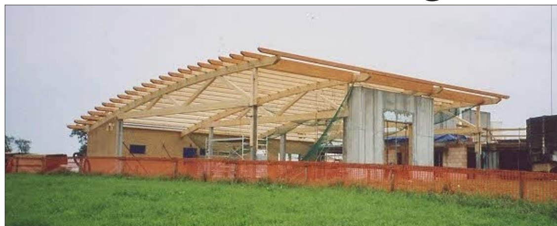
Baufortschritt in rekordverdächtigem Tempo. Spatenstich war im Juli, Firstfeier am 20. Oktober.
