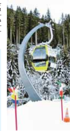
Die neu errichtete Senderbahn auf den Gipfel des Stubnerkogels geht mit Beginn der Wintersaison in Betrieb. BILD: GASTEINER BERGBAHNEN
